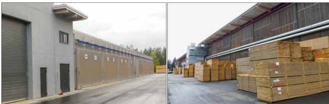
Rohware für die Brettsperrholzproduktion kauft die HBW ausschließlich frisch. Für die Trocknung stehen acht Trockenkammern mit einer Kapazität von insgesamt 1000 m<sup>3</sup> zur Verfügung.
